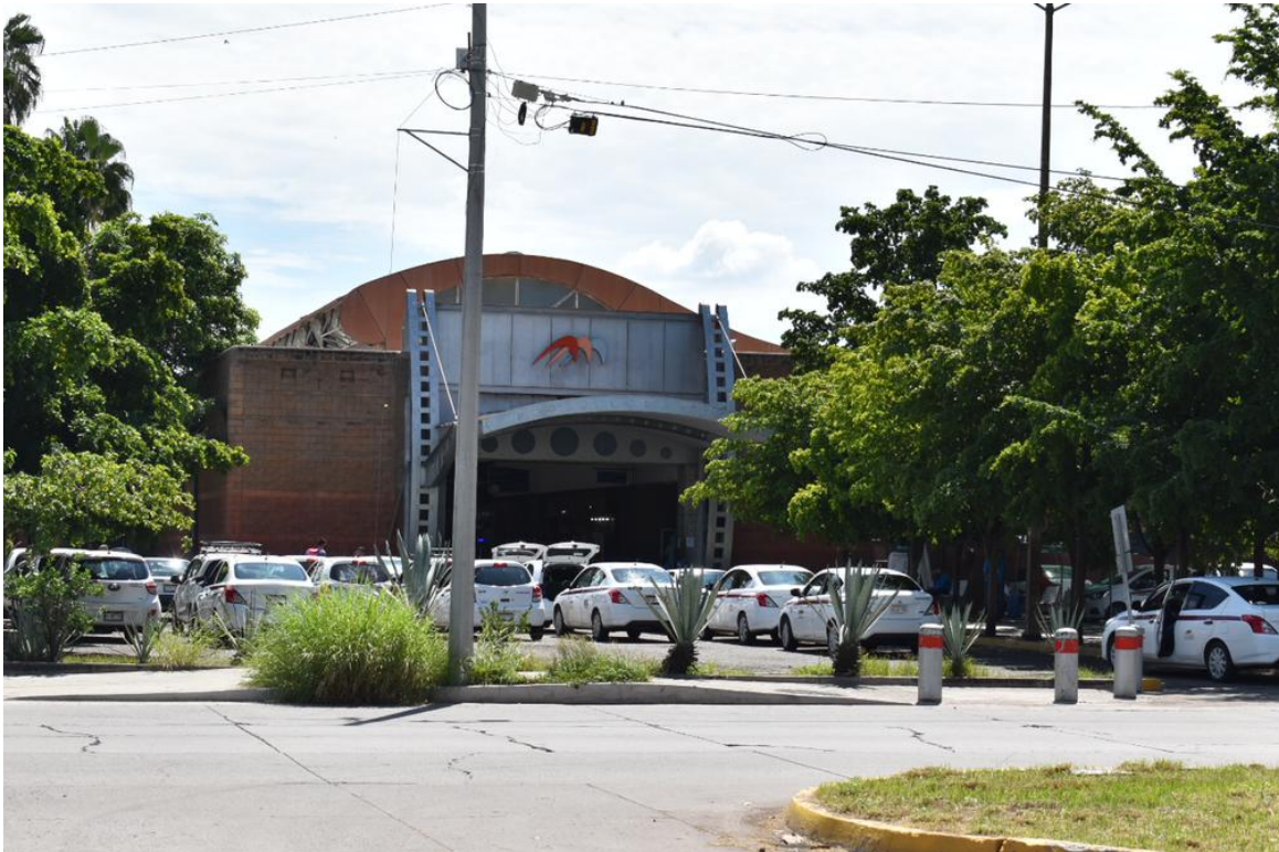
Figura 19. Central Camionera Millenium (2001)
