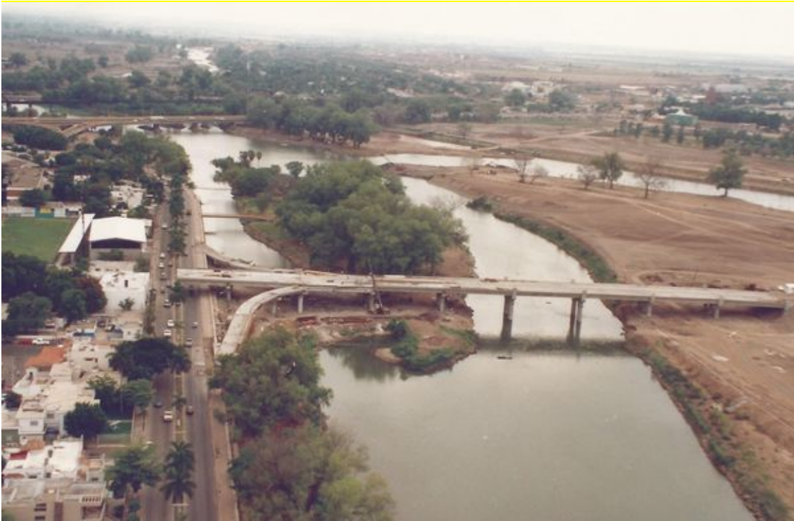
Figura 37. Construcción del Puente Juan de Dios Bátiz, 1993
