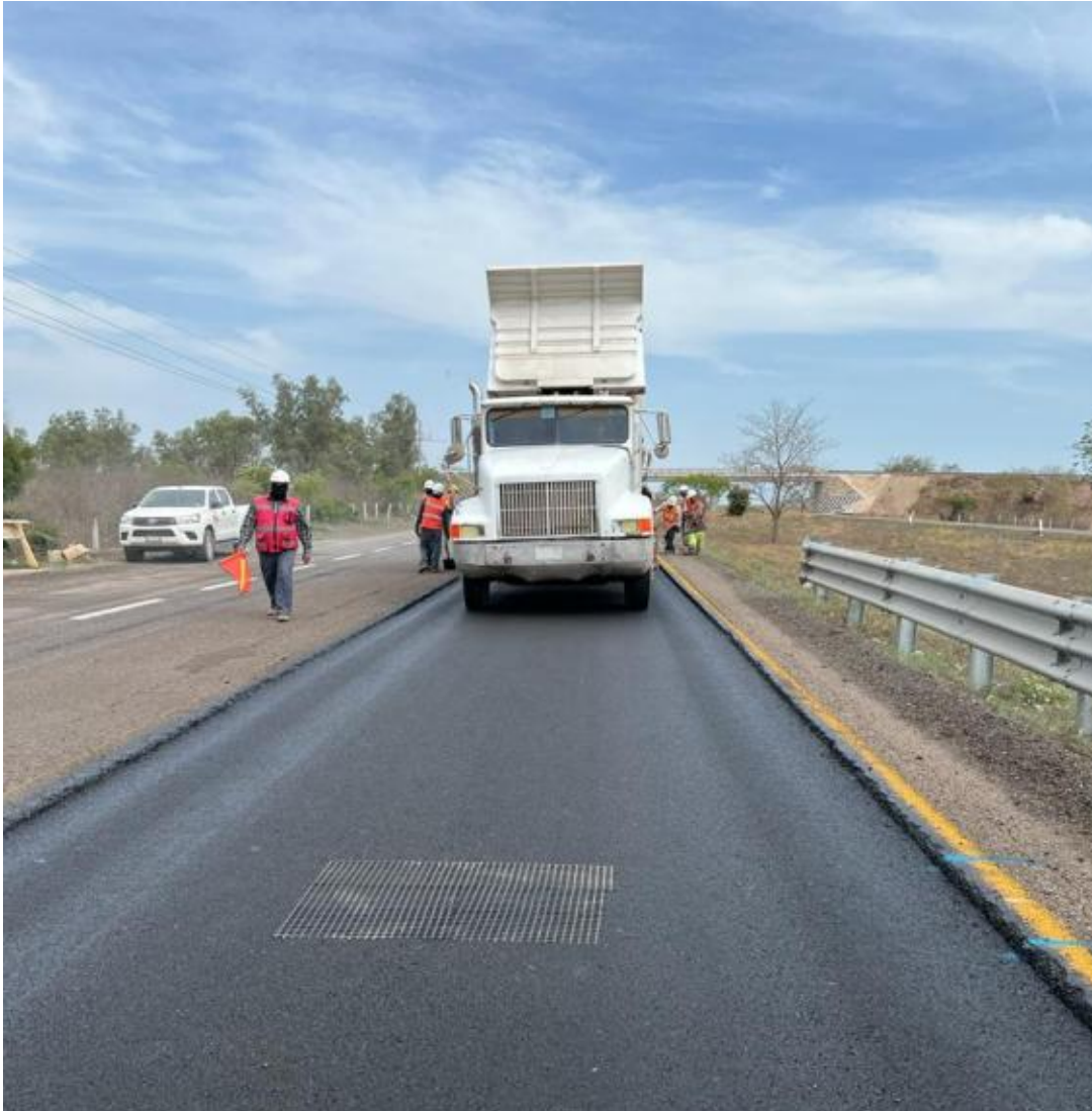
Fig. 21. Instalación de geomalla de fibra de vidrio.
