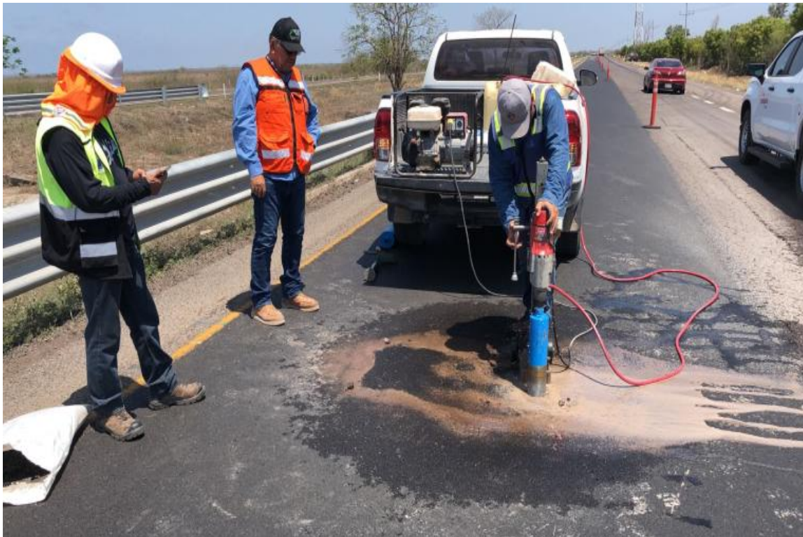
Fig. 17. Extracción de núcleos (Km 108+231 Culiacán - Mazatlán).
