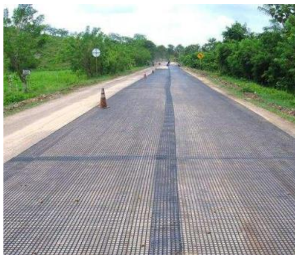
Fig. 14. Instalación del geosintético en vías públicas (TENSAR, 2020).
