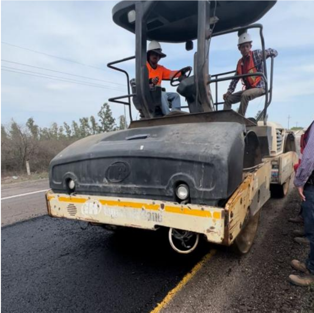
Fig. 15. Compactación de segunda capa de mezcla asfáltica km 108+231 de la carretera Culiacán – Mazatlán.
