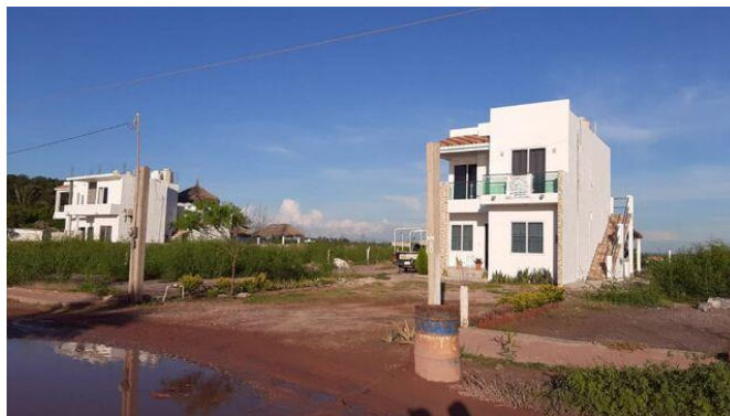
Ilustración 16. Construcciones en lugares no permitidos, que aparentemente gozan de permiso ejidal
