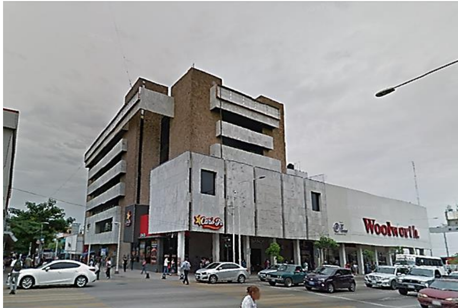
Figura 3.17 Edificio Banoro en la actualidad
