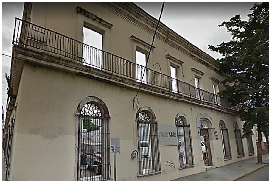
Figura 3.8 Construcción tipo señorial en la actualidad
