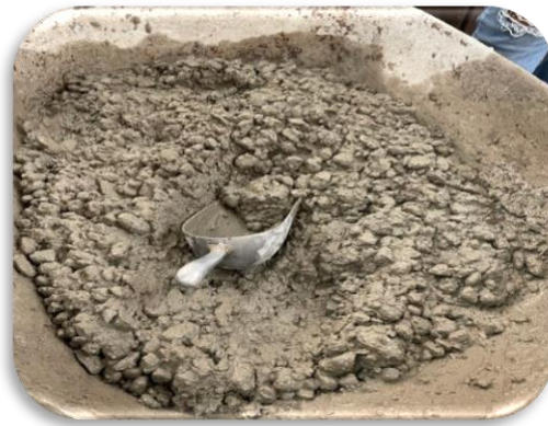
Figura 4. Mezcla de concreto.
