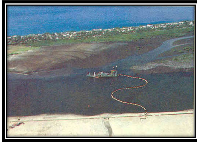
Imagen 9.- Dragado del Puerto Interior de San Pedrito en 1985.
