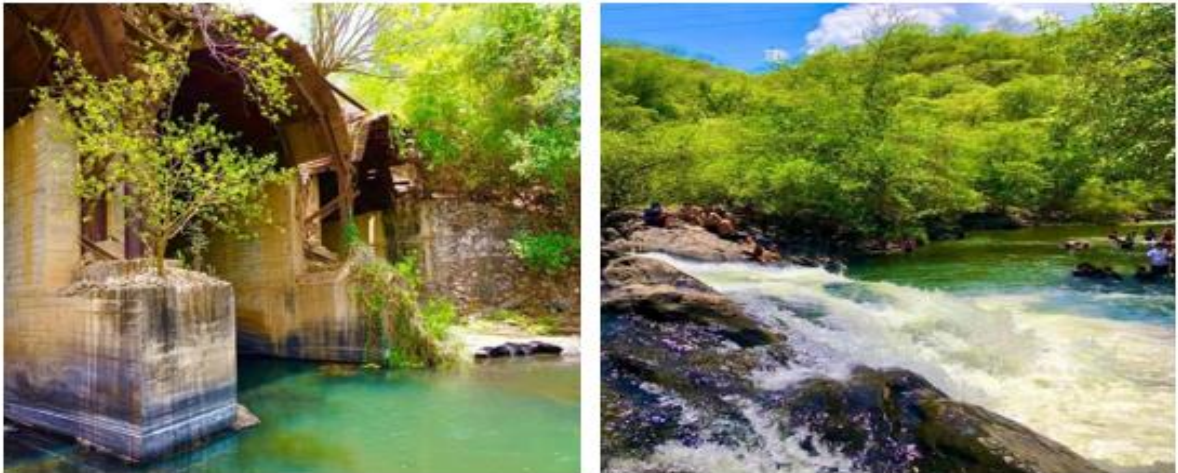
Figura 4.8. Arroyo Puente de fierro.
