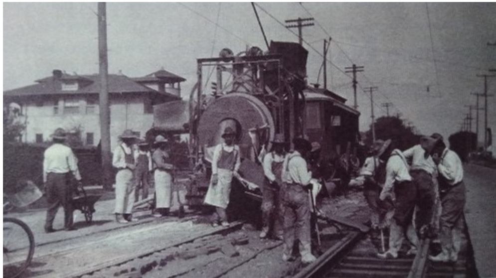
IMAGEN 16.-TRABAJADORES MEXICANOS EN EL TRAQUE, CONSTRUYENDO LAS VÍAS DEL TREN EN LOS ÁNGELES, 1903
