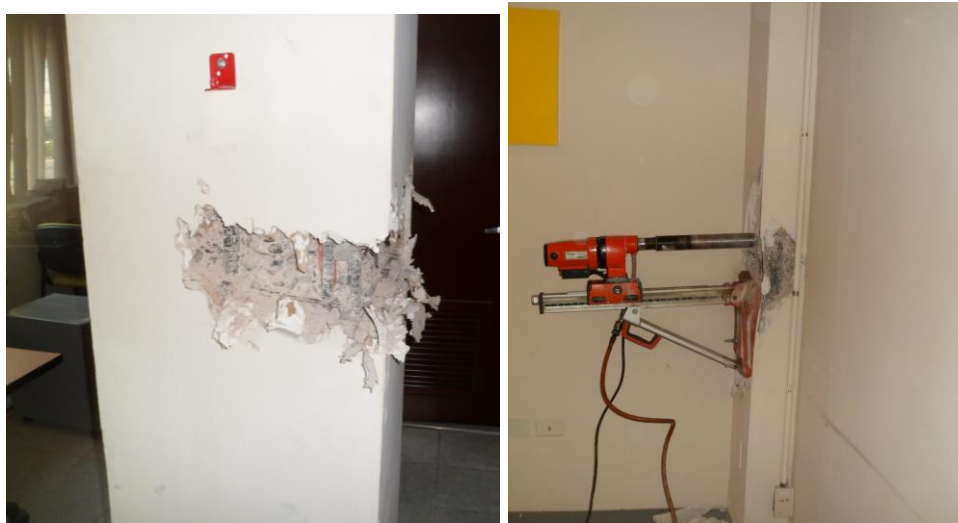
Figura 13. Escarificado y extracción de corazón de concreto en columnas.
