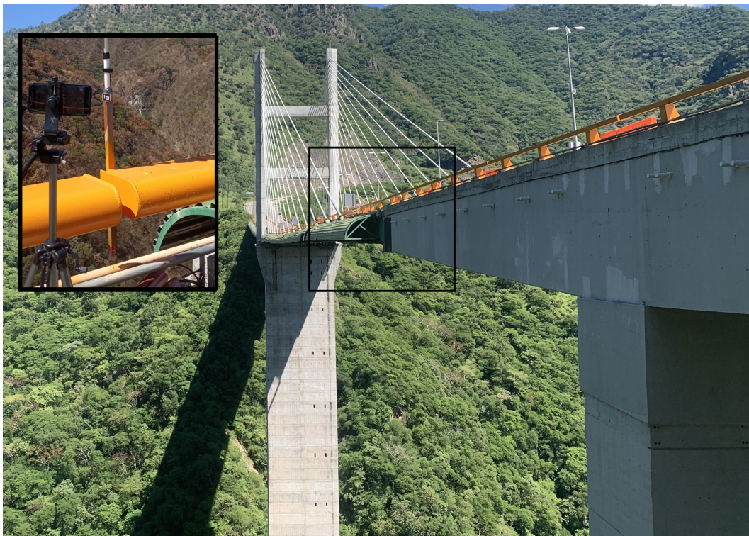
Figura 7.2: Prueba para determinar la frecuencia de vibrar del tablero.
