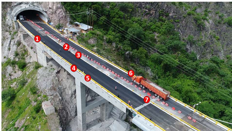
Figura 3.11: Puntos persistentes encontrados en el Puente El Carrizo.
