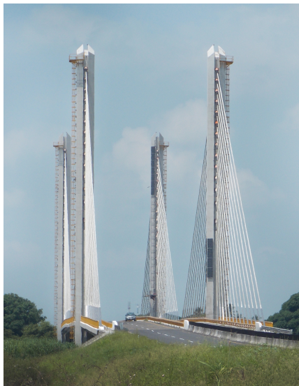
Figura 5.1: Puente Río Papaloapan.
