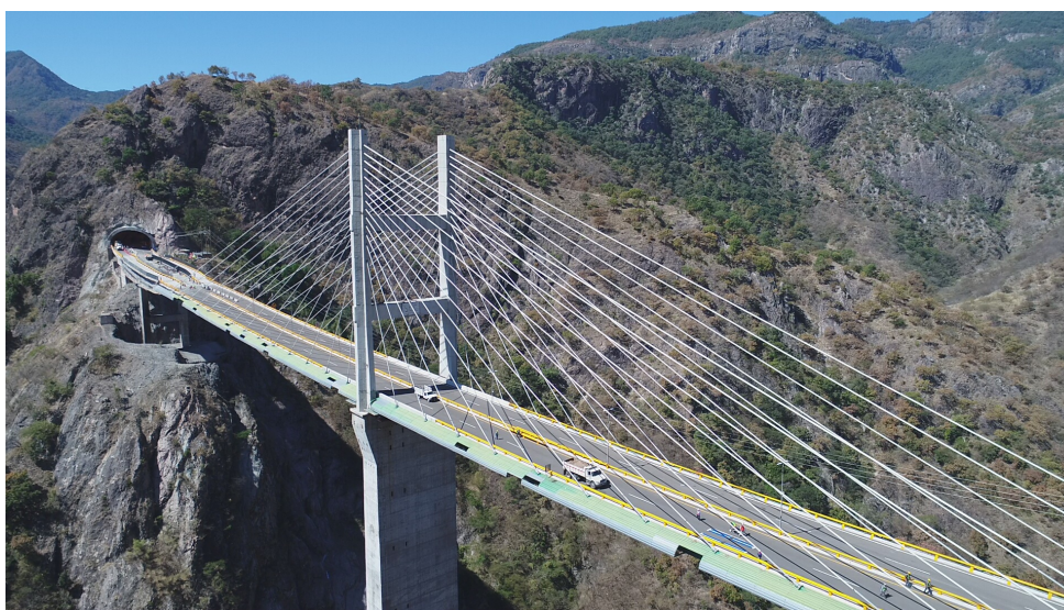
Figura 3.1: Vista longitudinal del Puente El Carrizo.
