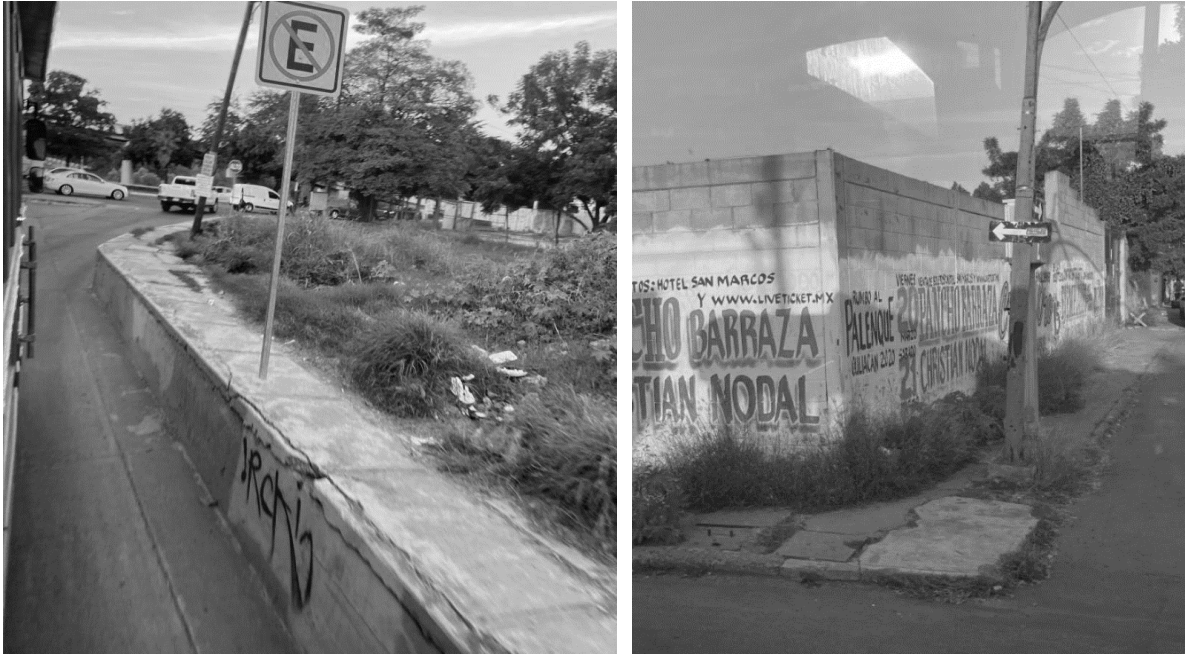
Imagen 16. Zonas con la falta de mantenimiento en el centro de la ciudad de Culiacán, Rosales. (Fuente: Fotografía propia, 08 de febrero y 08 de agosto del 2020).
