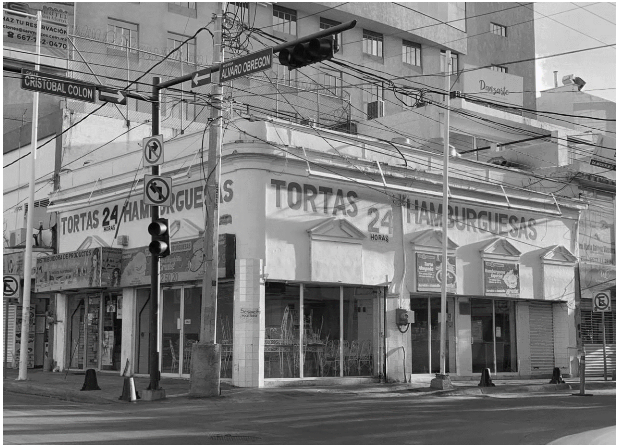
Imagen 14. Zona de oportunidad delictiva. Prol. Álvaro Obregón y calle Cristóbal Colon, Culiacán, Rosales. (Fuente: Fotografía propia, 18 de agosto del 2020).
