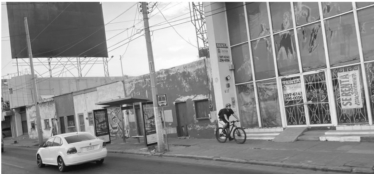
Imagen 17. Zonas con la falta de mantenimiento. Prol. Álvaro Obregón, en el centro de la ciudad de Culiacán, Rosales. (Fuente: Fotografía propia, 08 de agosto del 2020).
