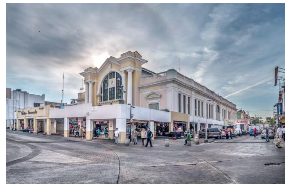
Mercado Garmendia, Fachadas oeste y sur
