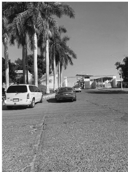
Figura 13. Planta Almacenadora de Pemex Culiacán, sobre Avenida Aztlán.
