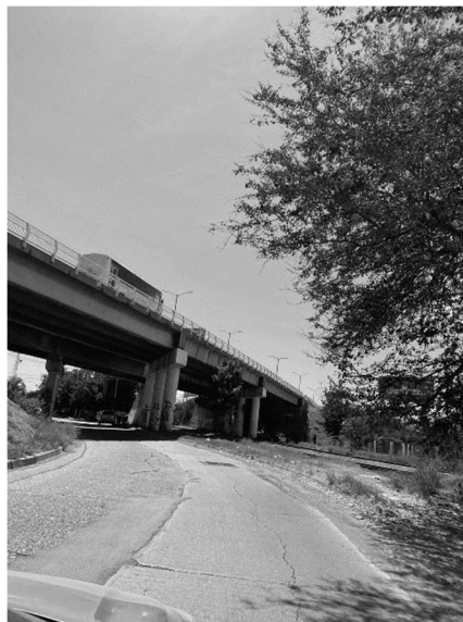
Figura 5. Acceso a Avenida Aztlán por Boulevard. Emiliano Zapata.
