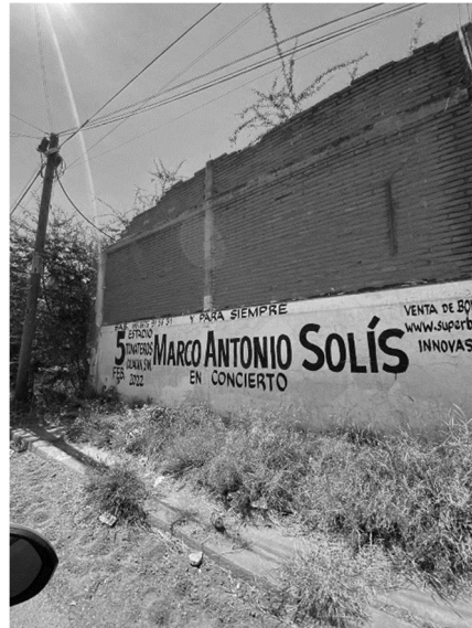
Figura 11 Condición de banquetas sobre Avenida Aztlán.
