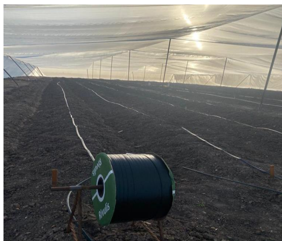
Figura 3. Instalación sistema de riego.
