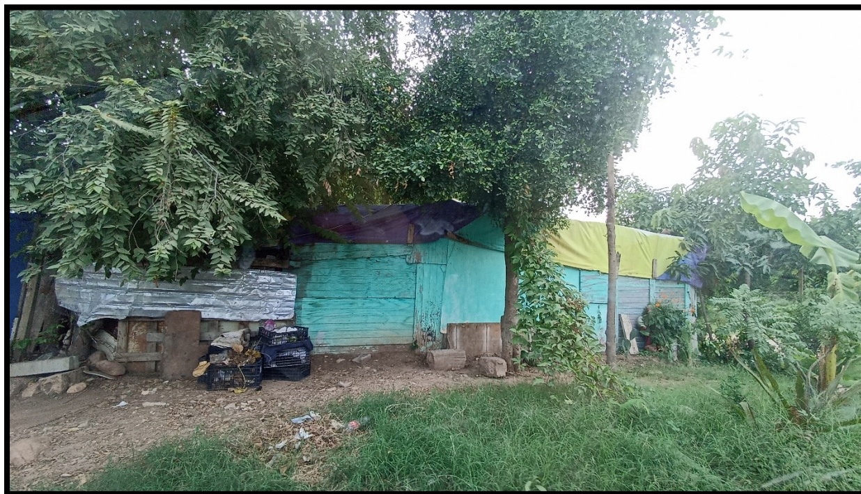
Figura 25. Vivienda inadecuada localizada en los límites del sector Barrancos y Lázaro Cárdenas
