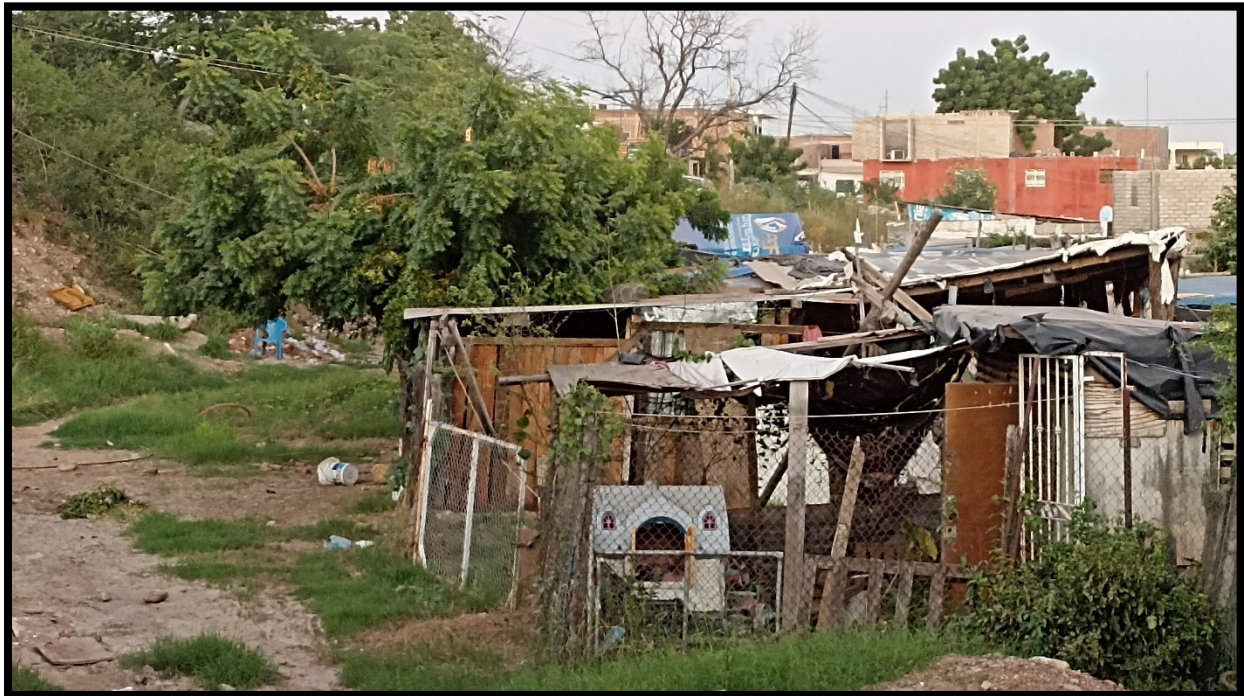
Figura 26. Vivienda inadecuada ubicada en el sector Barrancos
