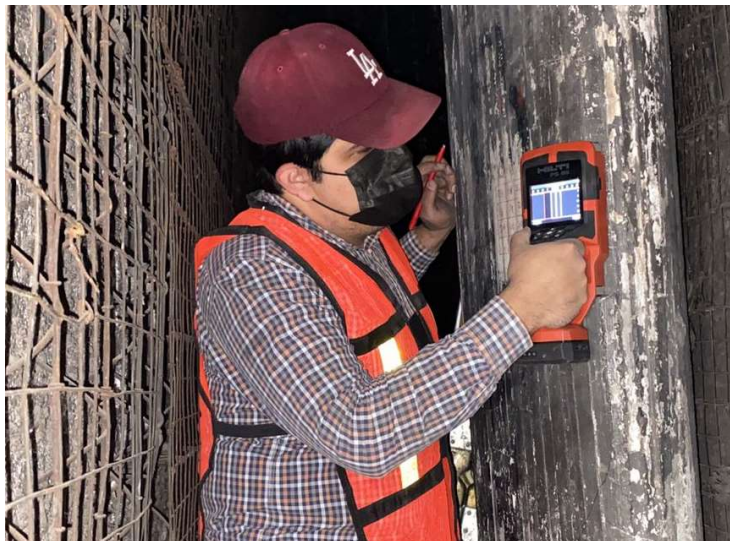
Figura 27.- Ubicación de acero de refuerzo con pachómetro.
