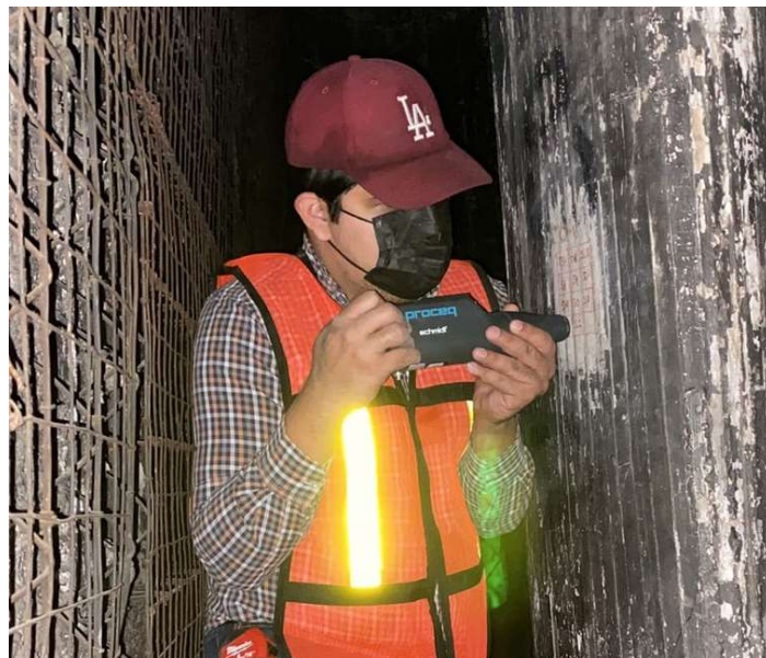
Figura 23.- Ejecución de prueba de esclerometría.
