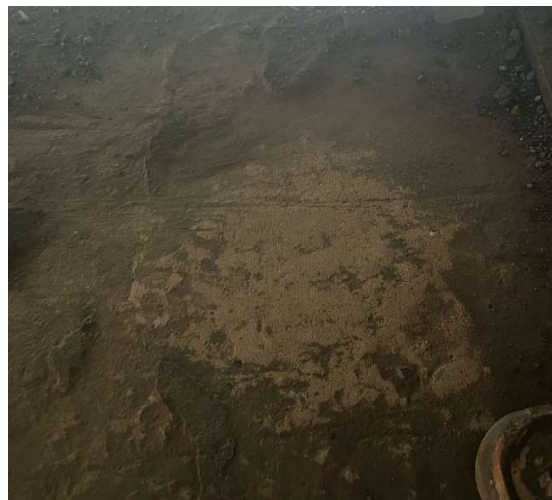
Figura 26.- Área preparada para prueba con pachómetro.
