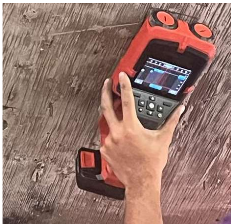
Figura 11.- Detección de acero de refuerzo con pachómetro.
