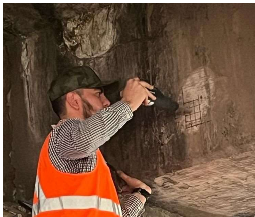
Figura 9.- Prueba de esclerometría a elemento de concreto.
