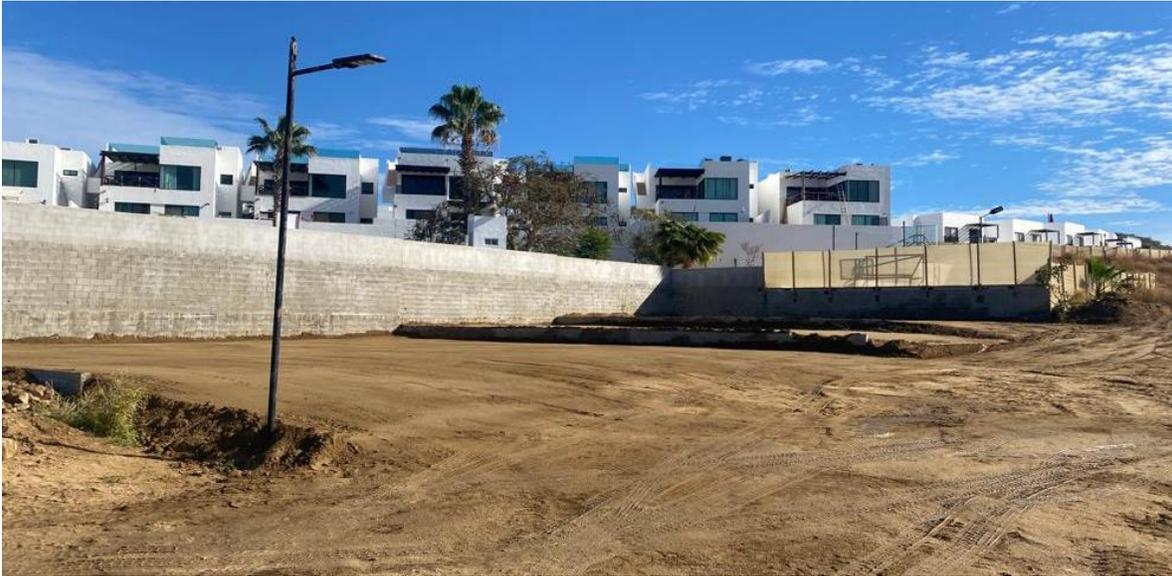
**Trazo y excavación de losa de cimentación.**
