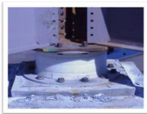
*Figura 2.8. Imagen real de un apoyo elastomérico, Bonilla.*
