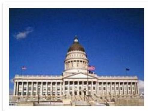
*Figura 2.13. Utah State Capitol. Utah, Estados Unidos. El sistema de aislamiento de la base se compone de 265 aisladores.*
